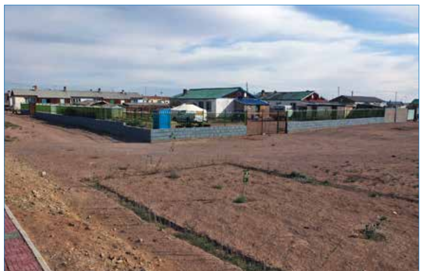
Baumpflanzungen und neue Umzäunungen (Foto: I. Stolpe, 2014)
