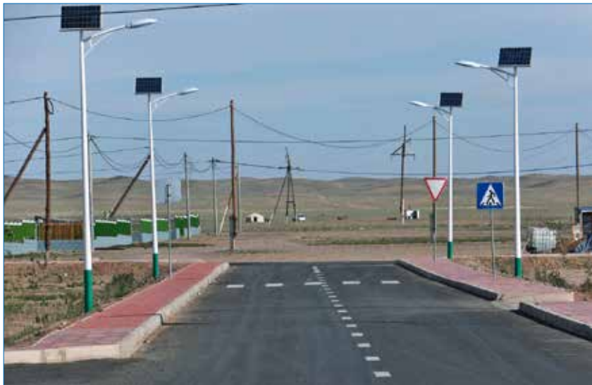
Neue Hauptstraße mit Solarbeleuchtung (Foto: I. Stolpe, 2014)
